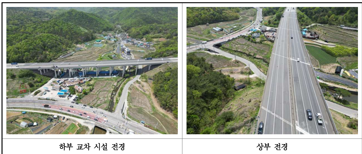
【사진 30.2.1】 주변환경 및 하중변화 전경
