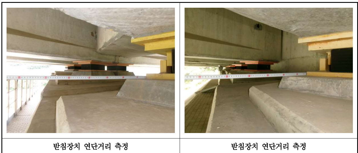
【사진 30.3.15】 교량받침장치 연단거리측정
