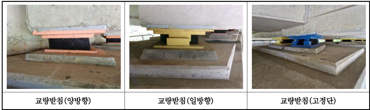
【사진 30.3.13】 교량받침 전경
