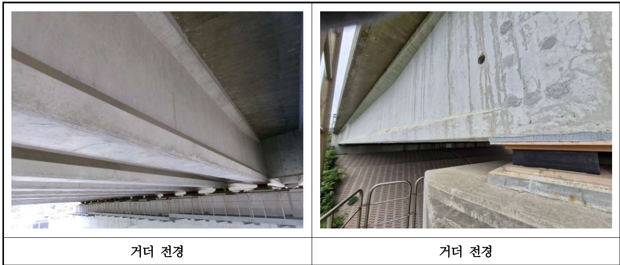
【사진 30.3.4】 거더 전경
