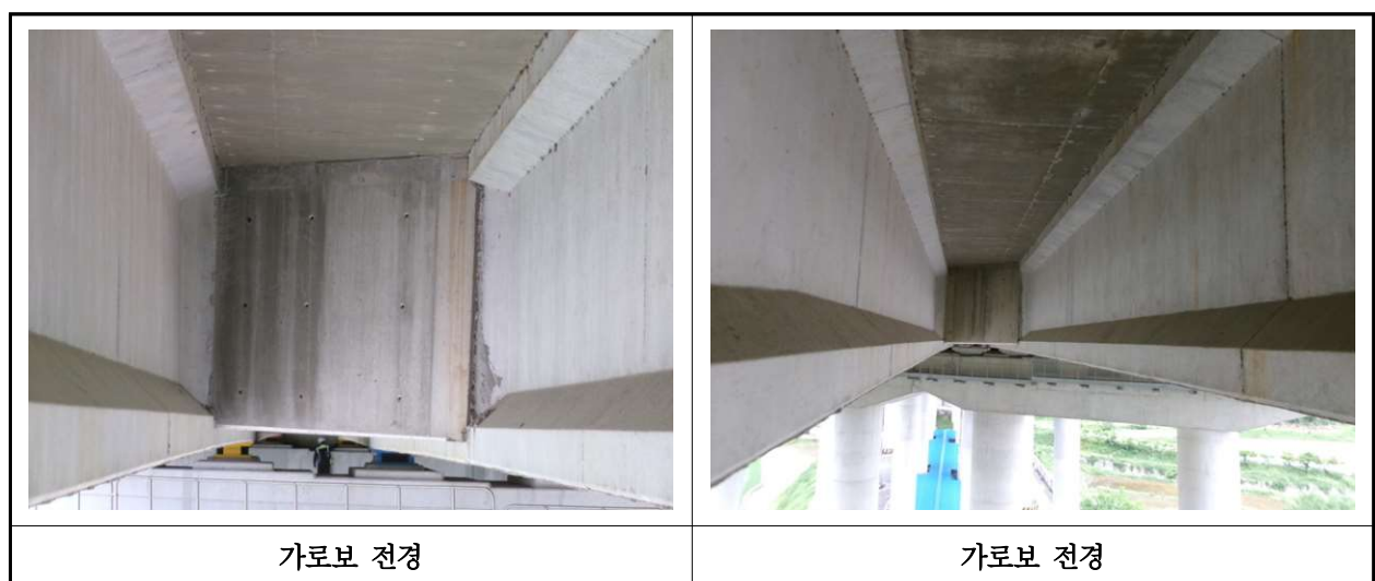
【사진 30.3.6】 가로보 전경
